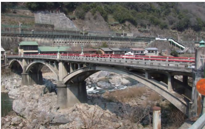
城嶺橋は名古屋開府 250 年を記念し、明治 42 年 (1909) 3 月に着工、翌年完成した木橋でした。初代の木橋は完成の翌年に大水で流出してしまい、大正元年 (1912) に吊橋で復旧しますが、昭和 11 年 (1936)、2 代目橋の下流側に平行して京都四条大橋を模してコンクリートアーチ橋建設に着工、翌年完成したのが 3 代目である現在の橋です。親柱に尾張徳川家 19 代義親氏による「城嶺橋」の揮毫があり、大正期の水平線・垂直線を強調する「セセッション」風デザインであった「まぼろしの四条大橋」の面影を残した橋として、貴重な近代化遺産となっています。
