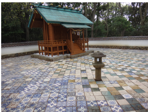
本殿と敷瓦(南西より)
