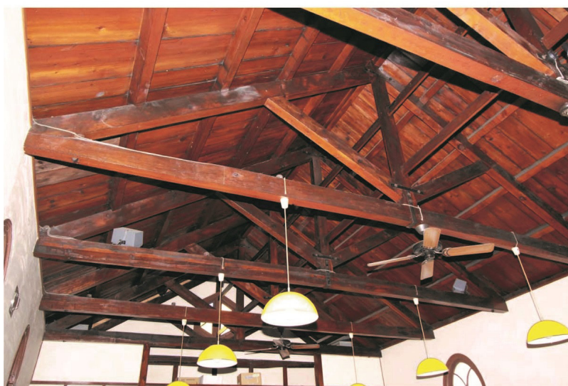
礼拝堂天井裏小屋組（南東より）
