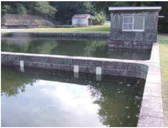
写真10 緩速ろ過池と観測小屋
