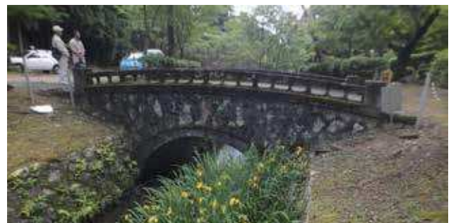
写真9 管理棟前のアーチ橋
