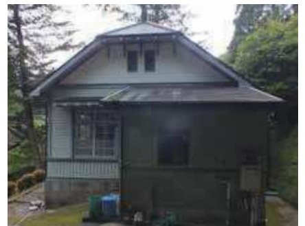
写真14 東側面の状況
