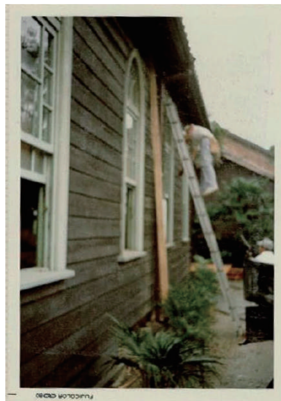
1980年改修中：礼拝堂外部、窓枠状況
