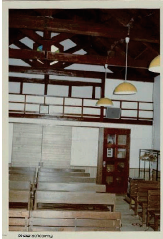
1980年改修後：礼拝堂内部
