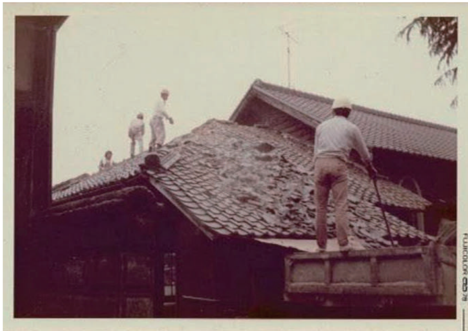
1978年改修：礼拝堂東側、旧CS撤去状況
