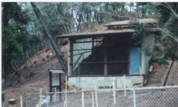
昭和 44 年に設置された旧覆屋
