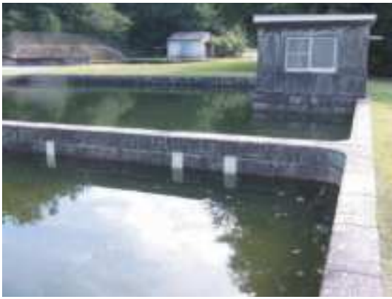
写真 10 緩速ろ過池と観測小屋
