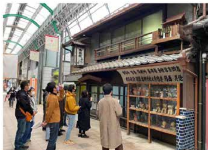
20年以上空き家となっている「松千代館」
