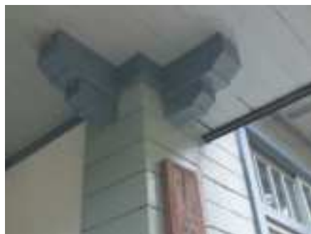
写真 13 玄関脇の柱と玄関底 の間につけられた持ち送り
