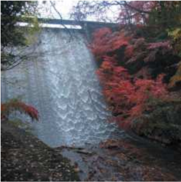
写真8 貯水池堰堤から溢流する水の波紋
