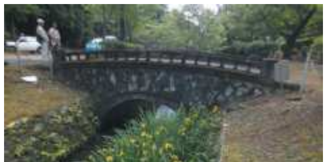
写真9 管理棟前のアーチ橋
