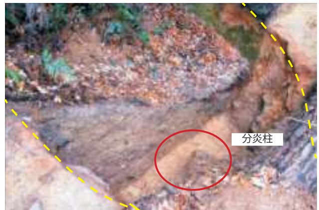
写真 1 椿 1 号窯跡検出状況
