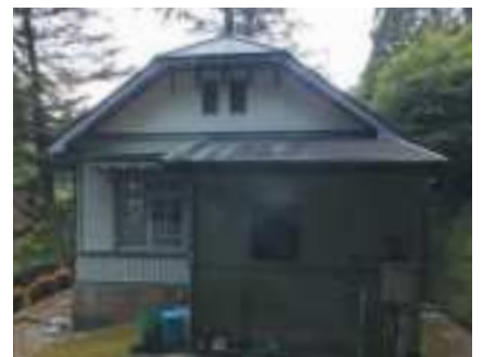
写真 14 東側面の状況
