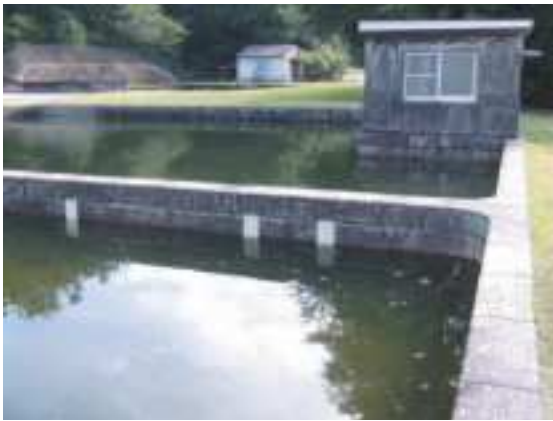
写真 10 緩速ろ過池と観測小屋
