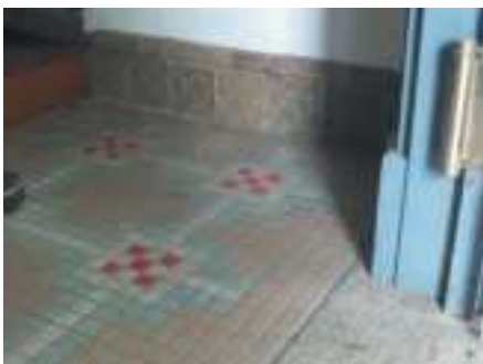
写真 12 玄関土間側面の巾木 に貼られたスクラッチタイル
