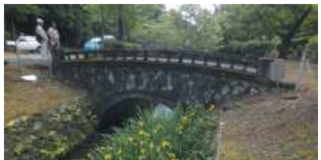
写真9 管理棟前のアーチ橋
