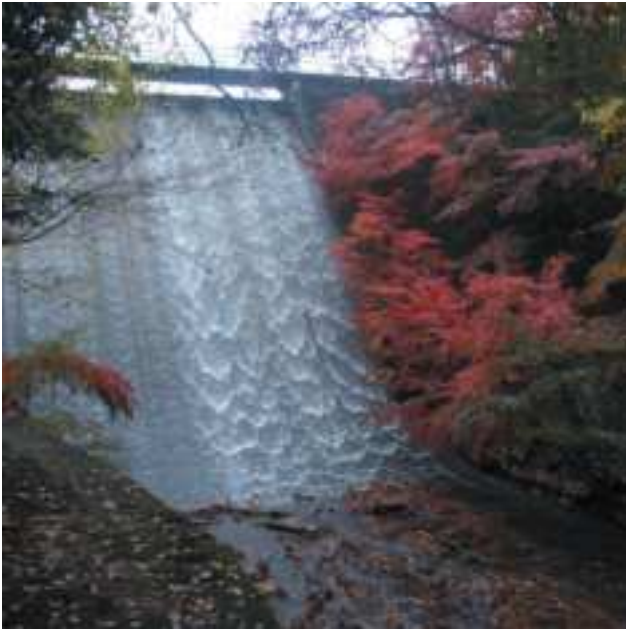
写真8 貯水池堰堤から溢流する水の波紋
