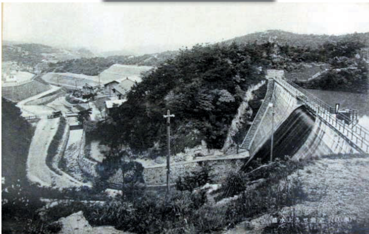
写真7 竣工(昭和8(1933)年)当時の馬ヶ城浄水場(フォトスタジオ伊里撮影)
