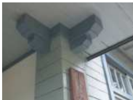
写真13 玄関脇の柱と玄関庇 の間につけられた持ち送り
