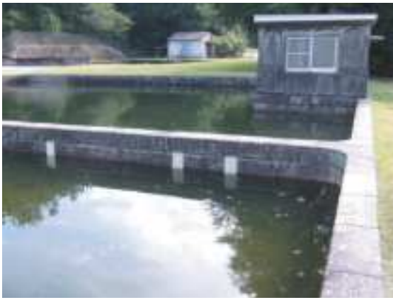
写真10 緩速ろ過池と観測小屋
