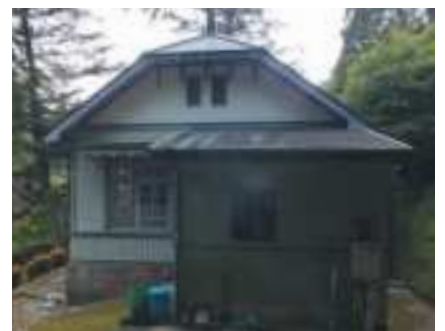
写真14 東側面の状況
